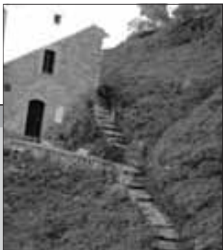
I lavori in corso
